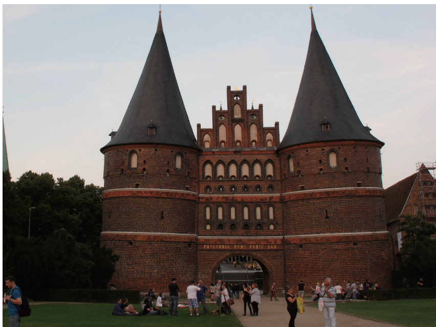
沉實穩重的荷爾斯坦城門
